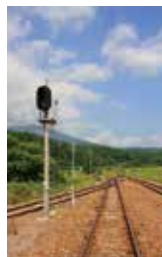
松尾八幡平駅。この先が急登区間
